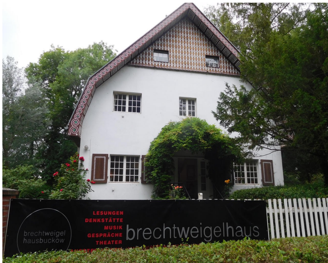
Fotos 1 e 2. Casa de campo de Brecht/Weigel, na cidade de Buckow, perto da fronteira da Polônia. Estas duas são fotos da casa, do ponto de vista da estrada por onde se chega.
