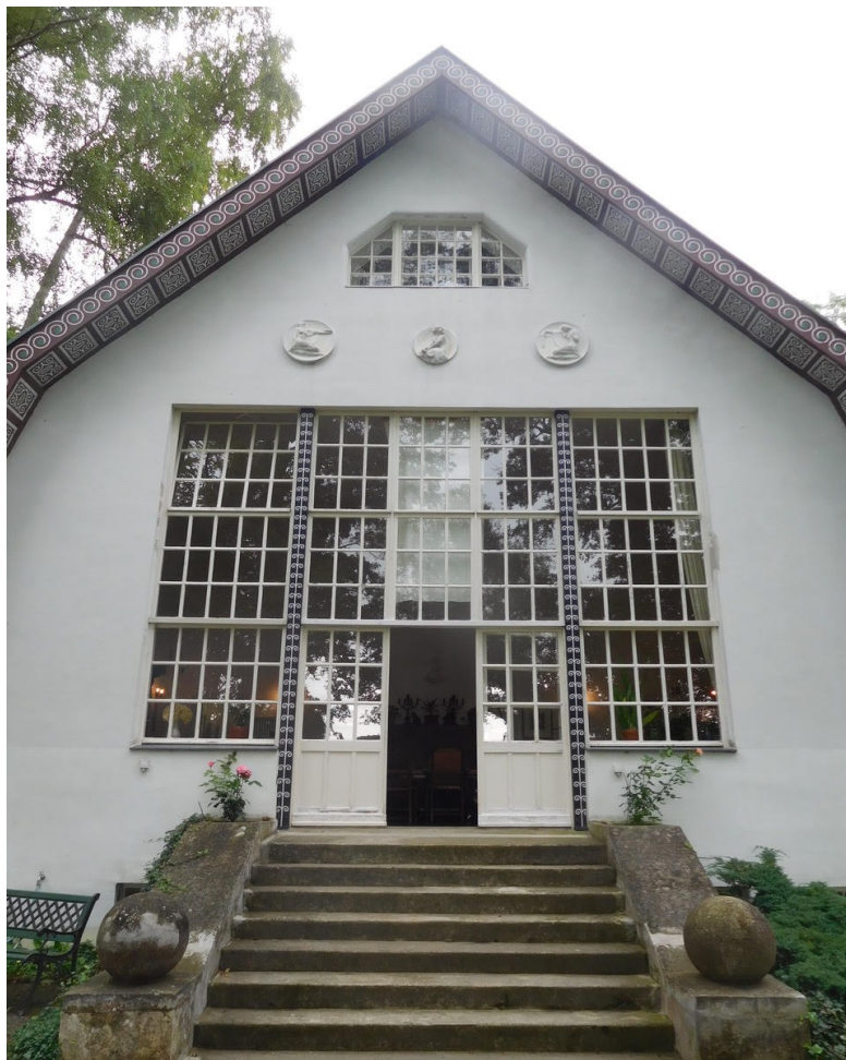
Foto 4. Casa vista dos fundos.
