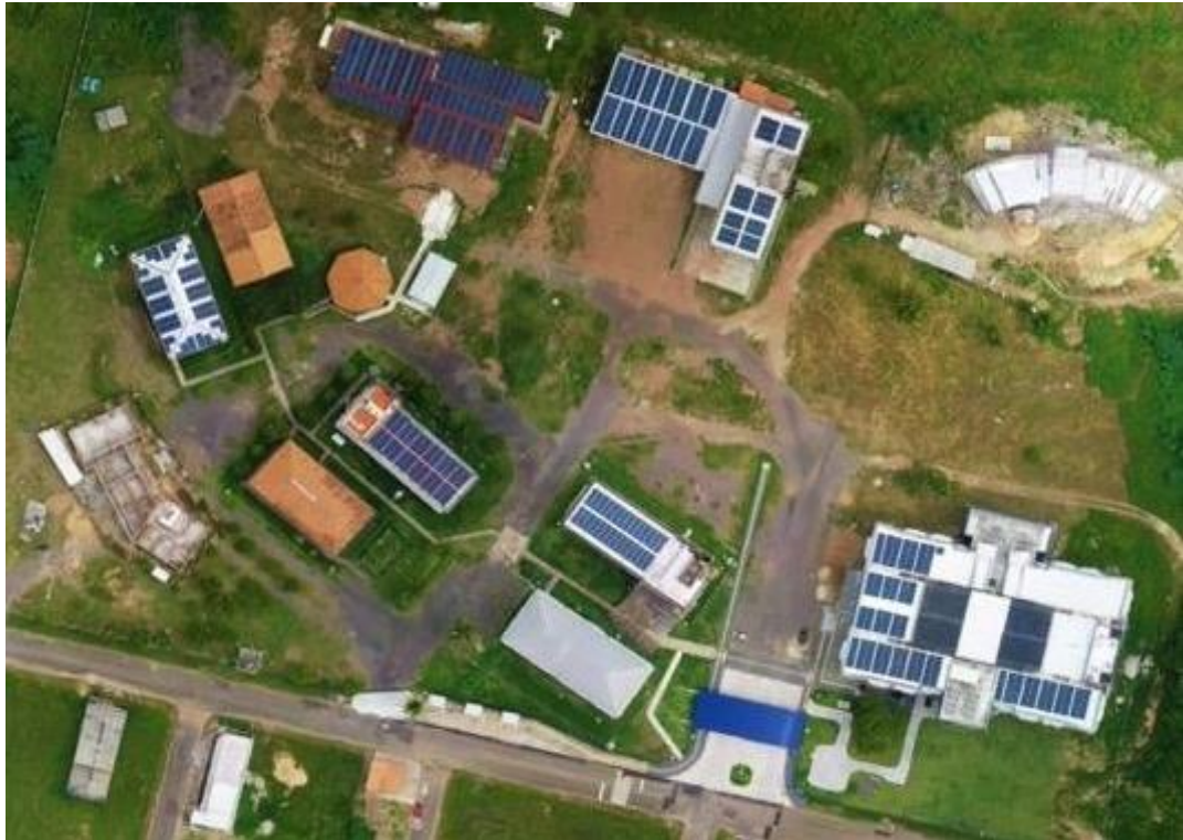
Figura 13: Parque de geração de energia solar da Unifesspa
