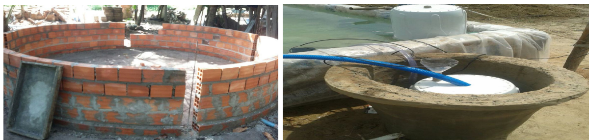
Figura 2 – Tanque de tijolo e cimento
